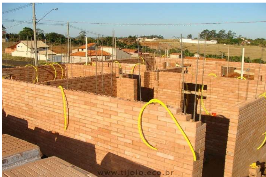
Figura 13 – construção com tijolo ecológico
