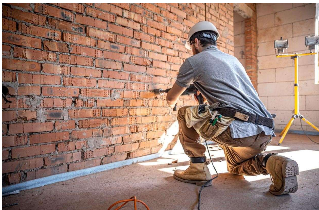
Figura 2 – Construtor manuseando um perfurador
