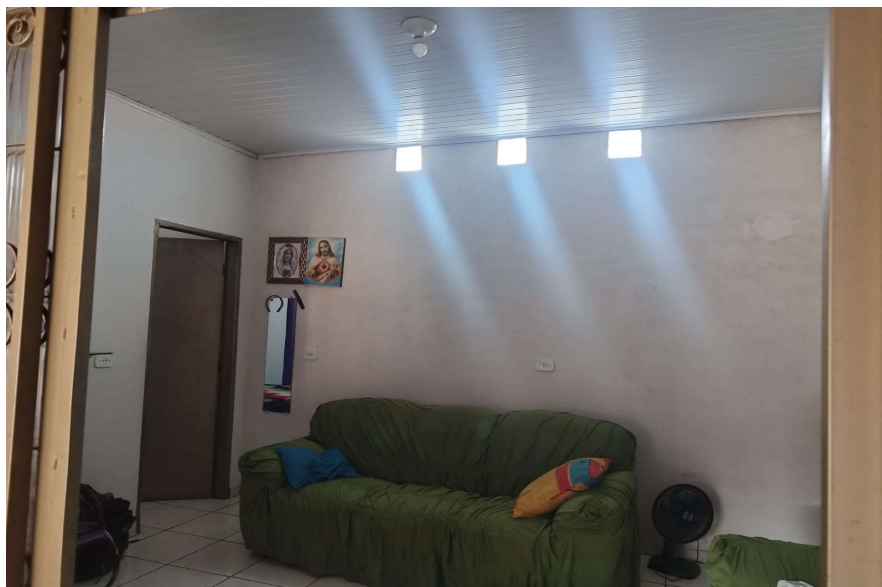
Figura 7 – iluminação com tijolo de vidro
