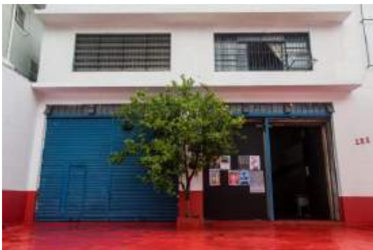
Figura 10: Fachada da interna do Galpão Casa1.
