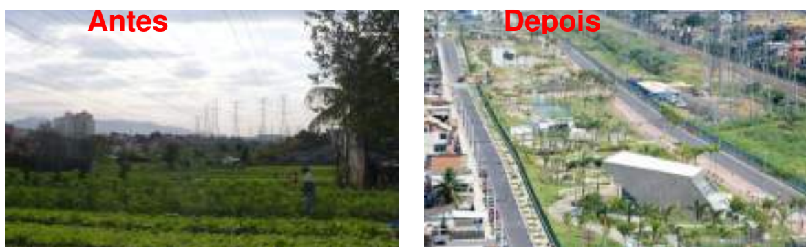
Figura 27: Faixa de servidão da light antes e depois
