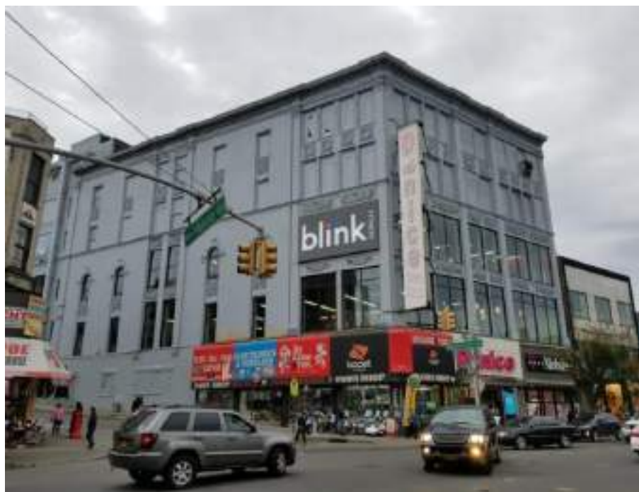
Figura 4: Antigo Edifícios Sachs
