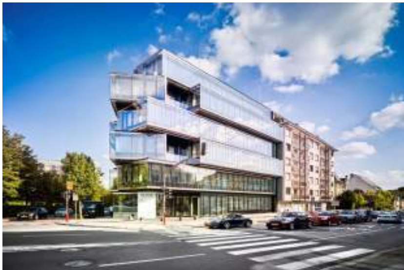
Figura 17 - Edifício One on One - Fachada principal
