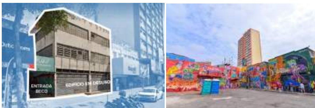
Figura 20: Entrada Beco da Codorna Av. Anhanguera e o beco internamente.
