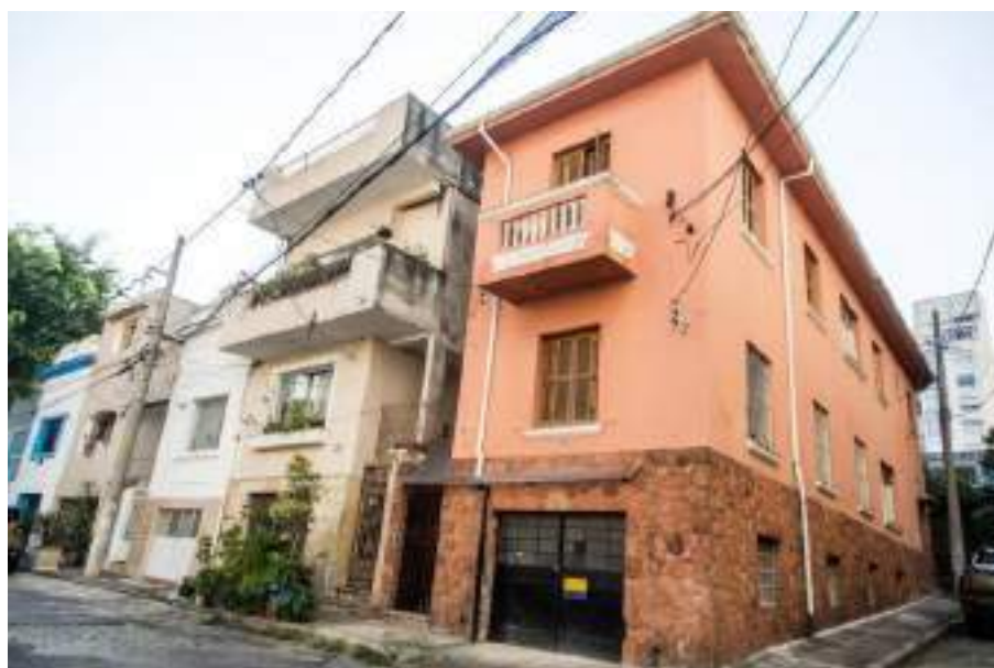
Figura 12: Fachada da Clínica Social.
